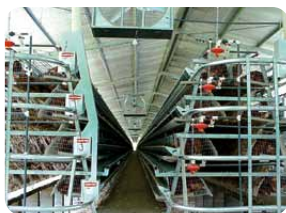
Control de temperatura
