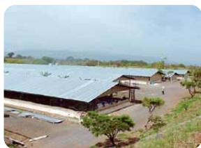
Cubierta colocada post aislamiento
